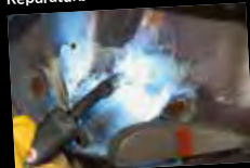
Lückenfüller: Bleche selbst anfertigen und einschweißen
